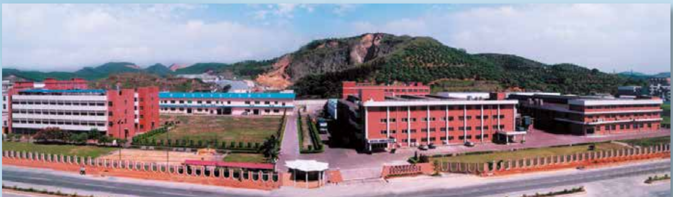
東莞廠 Dong Guan Plant
